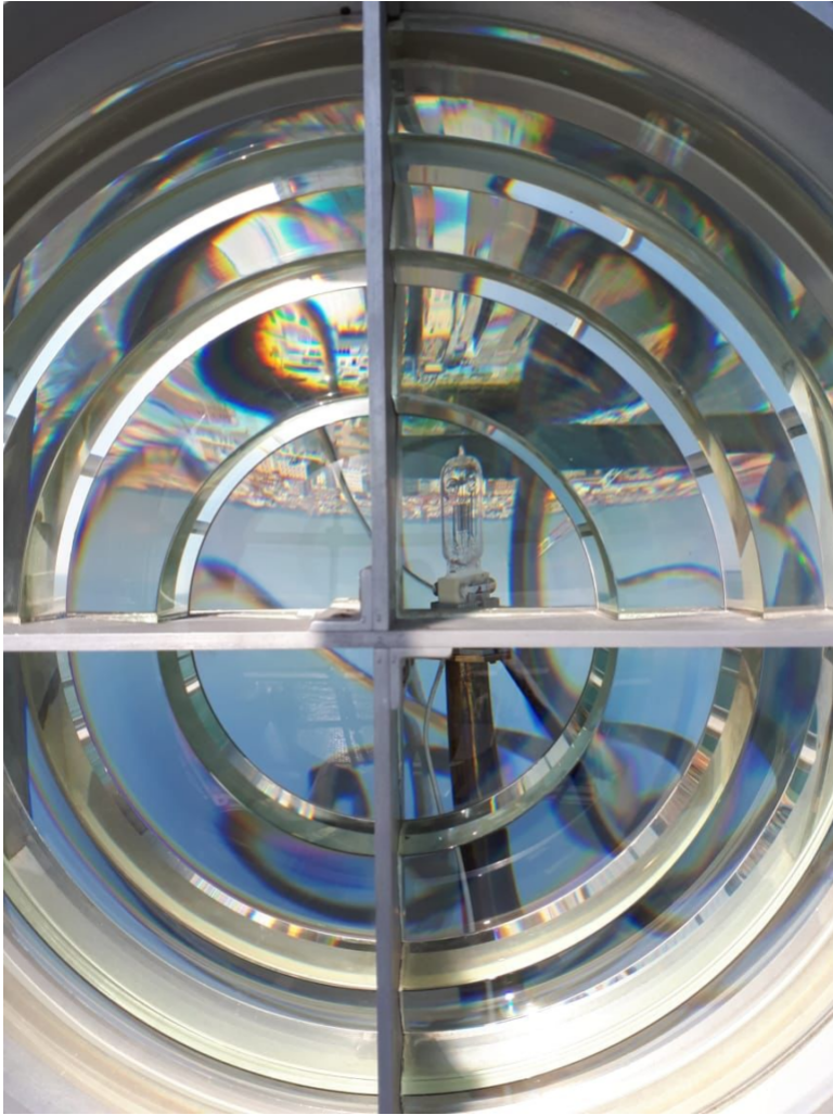
La lente della lanterna di Livorno con la nuova lampada a scarica di gas
