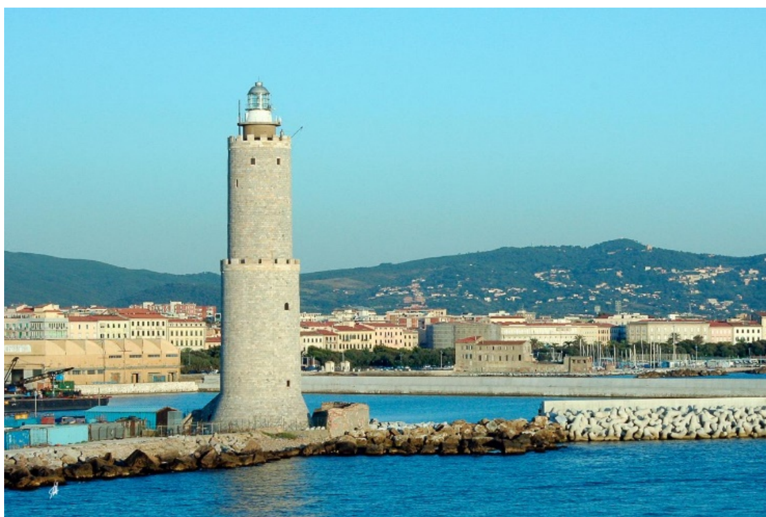
Faro di Livorno dopo i lavori di manutenzione straordinaria degli anni 2000
