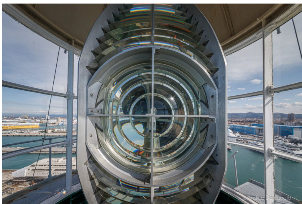
La lente di Fresnel nel Faro di Livorno con la lampada da 1000 W utilizzata fino al 2020. (Foto Dani)
